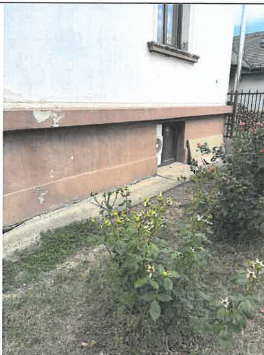
Fig. 2 Degradari soclu
