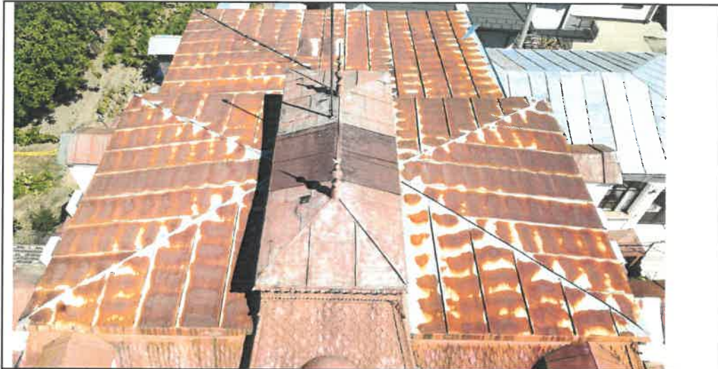
Fig. 5 – Degradari ale invelitorii din tabla
