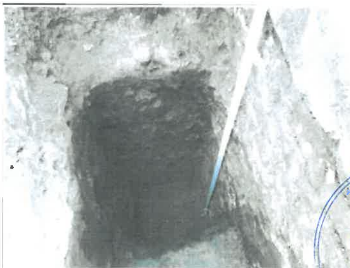
Decopertare a fundatiei
